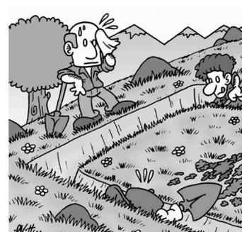
Si andava in profondità fino a quando non si trovava la terra compatta; la terra rossa 'vergine' era garanzia di appoggio sicuro per i muri portanti, mentre, in caso di terreno umido, si provvedeva a posizionare massi di medie e grandi dimensioni per rendere più sicura la superficie di appoggio.
