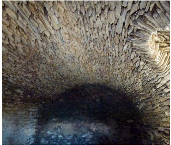
Nella maggior parte dei casi le volte sono orientate verso i muri laterali rispetto alla porta di ingresso situata sul fronte aperto. Raramente si possono trovare volte con l'arco poggiante sul muro di fondo ed il muro opposto.
